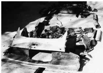
Was vom Tage übrig blieb – herausgetrennte marode Bleche
