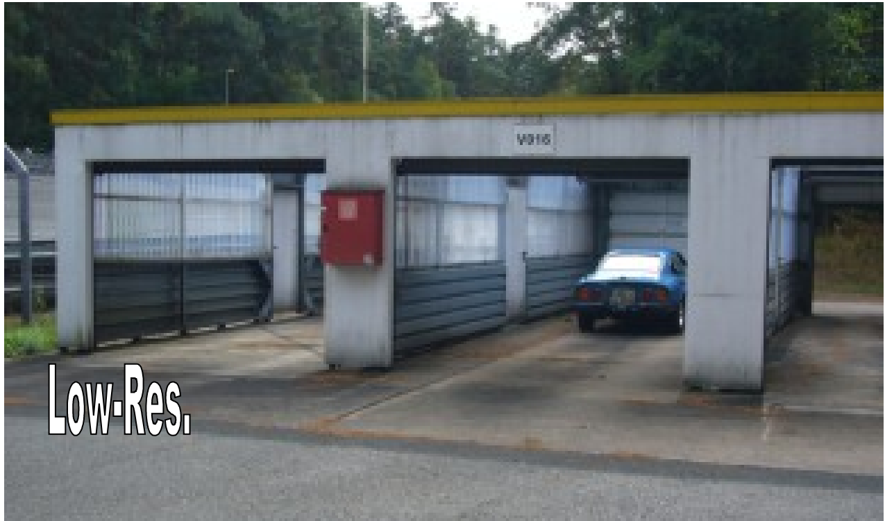
Abbildung 10: Das Windkreuz! Mit Erlaubnis durfte ich meinen GT in den original Prüfstand in Dudenhofen einfahren. Sicher das erste Mal seit Jahrzehnten, das hier ein GT steht! Im Hintergrund erkennt man die erhöhte Schnellfahrbahn. Die „Garagen“ sind oben offen, waren bisweilen mit starken Heizstrahlern ausgestattet, um die Sonnenlast nachzustellen.
