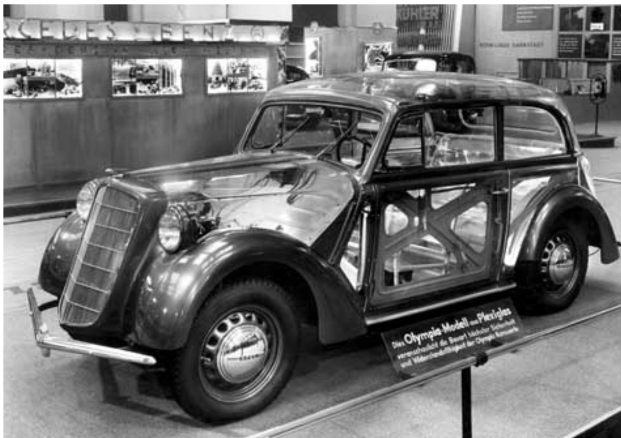
Mit einer Karosserie, die zum Teil aus Plexiglas bestand, veranschaulichte Opel das selbsttragende Bauprinzip. Am 19. September 1934 war das „sprengwerkartige Wagenkastengerippe“ von Opel zum Patent angemeldet worden.
